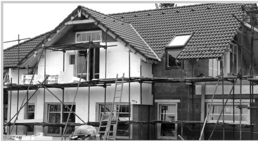
Při zateplování fasády se stavbaři postarali o polystyrénové „jarní sněžení“. Podoba školky se tak opět o něco přiblížila finální fázi, jakou jí předurčila architektka Ing. Buzická.
