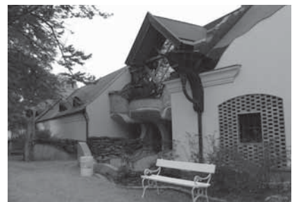
Štířín – Dům Atis, kovaná zábradlí.
